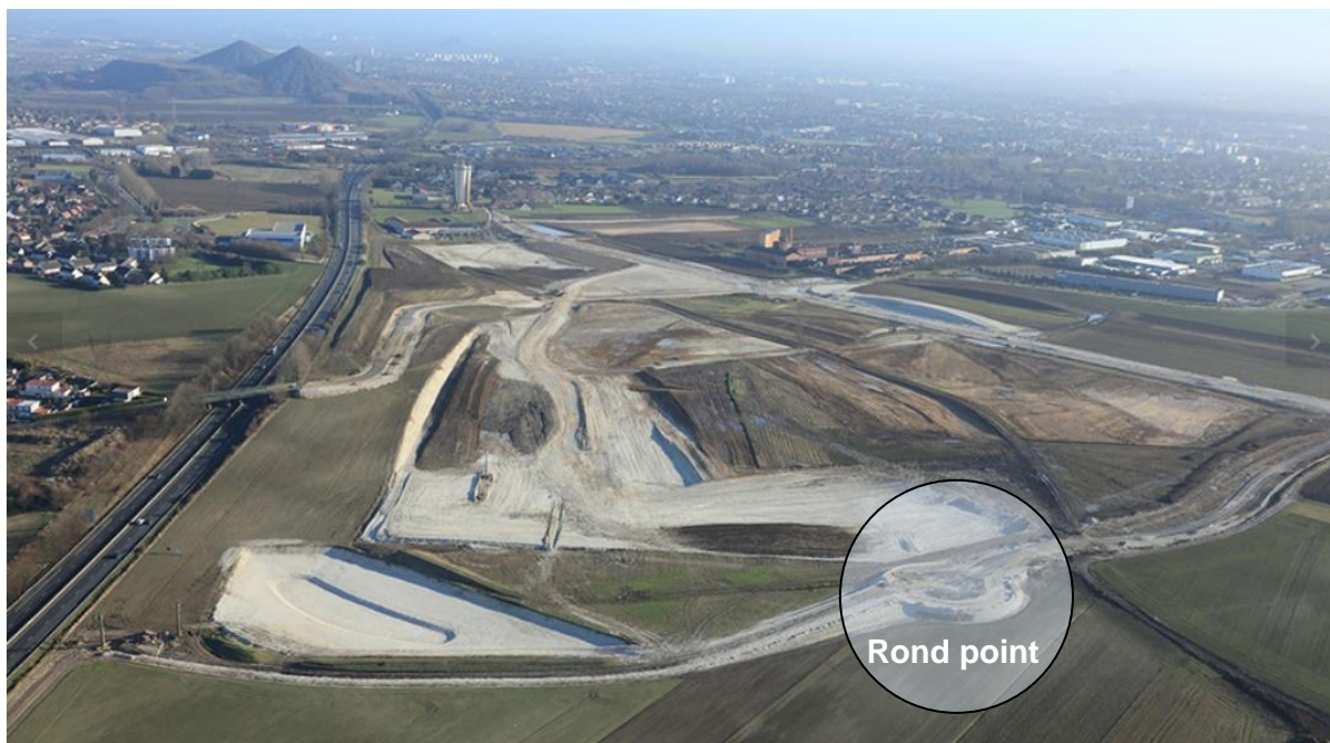
Vue aérienne (vers l'est) des parcelles en cours d'aménagement situées à l'est du projet (Source : Territoire 62)
